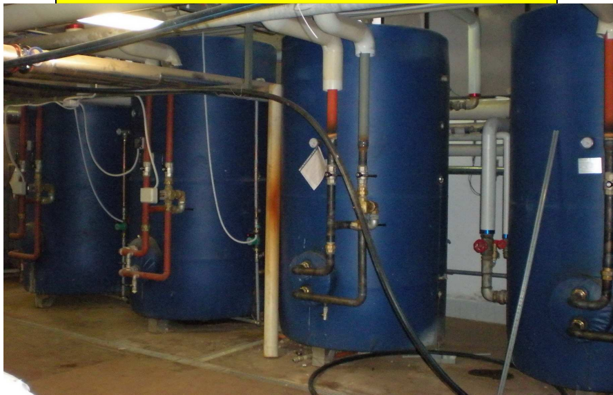
Spurgo boiler dal fondo
